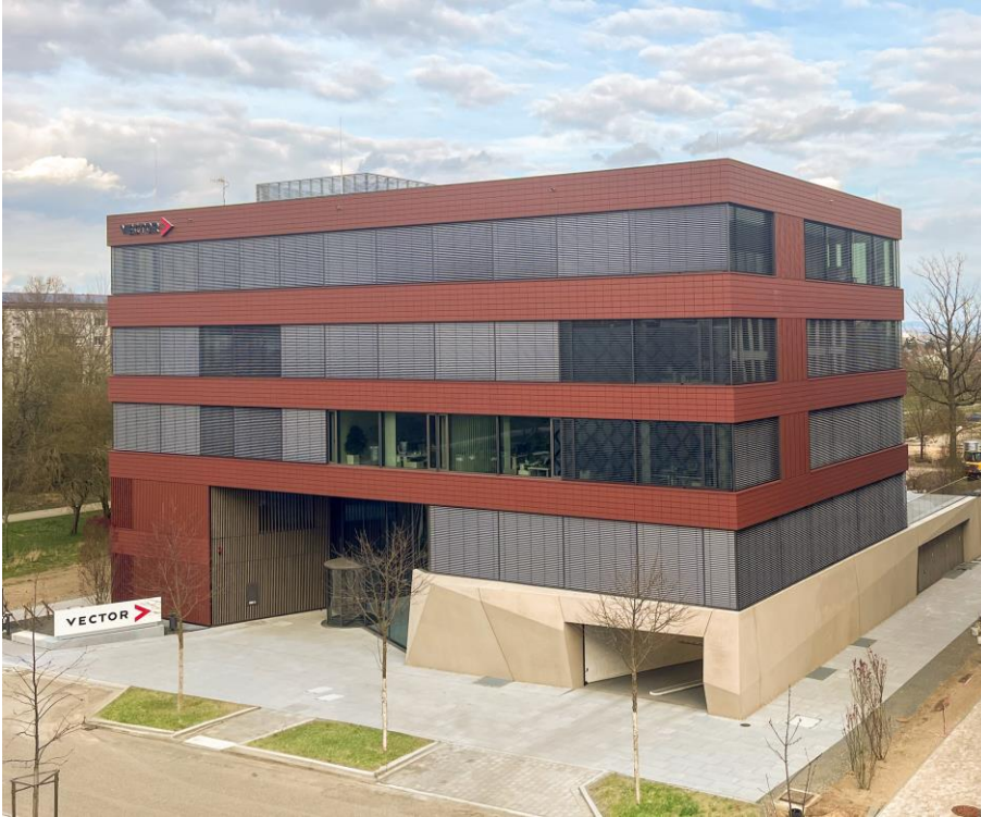
Bild 1: Die Außenfassade des neuen Vector Bürogebäudes besteht – wie bei allen Vector Gebäuden - aus viel Glas und Keramikplatten mit einem eigens kreierten dunkelroten Farbton – passend zur Unternehmensfarbe von Vector.
