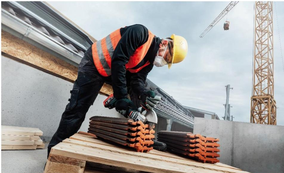
Mobiles Kraftpaket: Dachziegel und Steinplatten lassen sich mit dem WB 18 LTX BL 180 kraftvoll trennen. Das geringe Gewicht und die optimale Ergonomie des Akku-Werkzeugs erleichtern anspruchsvolle Aufgaben fernab der Steckdose – wie etwa das präzise Zuschneiden von Ziegeln um Dachfenstereinfassungen oder Dachkehlen. **Foto: Metabo**
