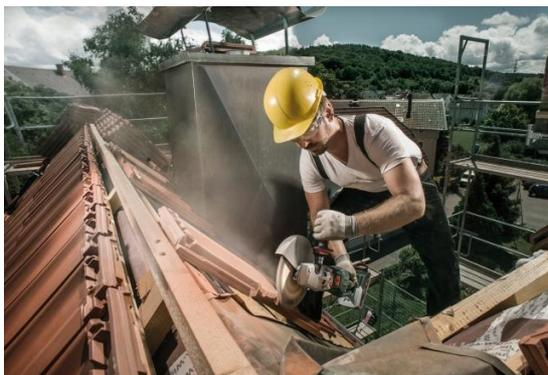
Der WPB 36 LTX BL 230 von Metabo ist der weltweit erste Akku-Winkelschleifer für Scheiben mit 230 Millimetern Durchmesser. Auf dem Leistungsniveau einer 2.400-Watt-Netzmaschine sind mit der neuen 36-Volt-Akku-Maschine bis zu 77 Millimeter tiefe Trennschnitte fernab der Stromversorgung möglich. **Foto: Metabo**
